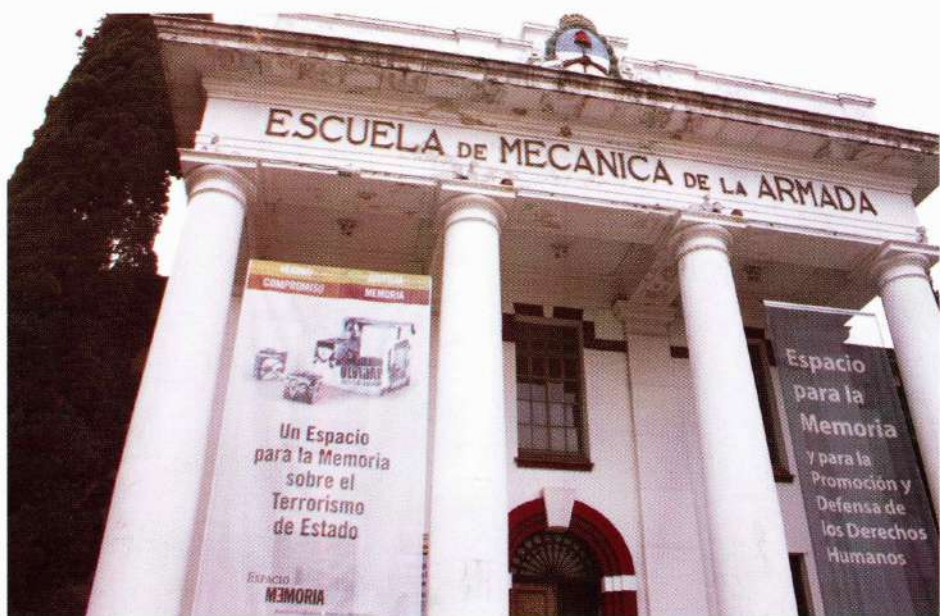
FRENTE EDIFICIO CUATRO COLUMNAS
