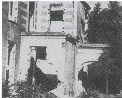
Edificio original de la Mansión Seré.
